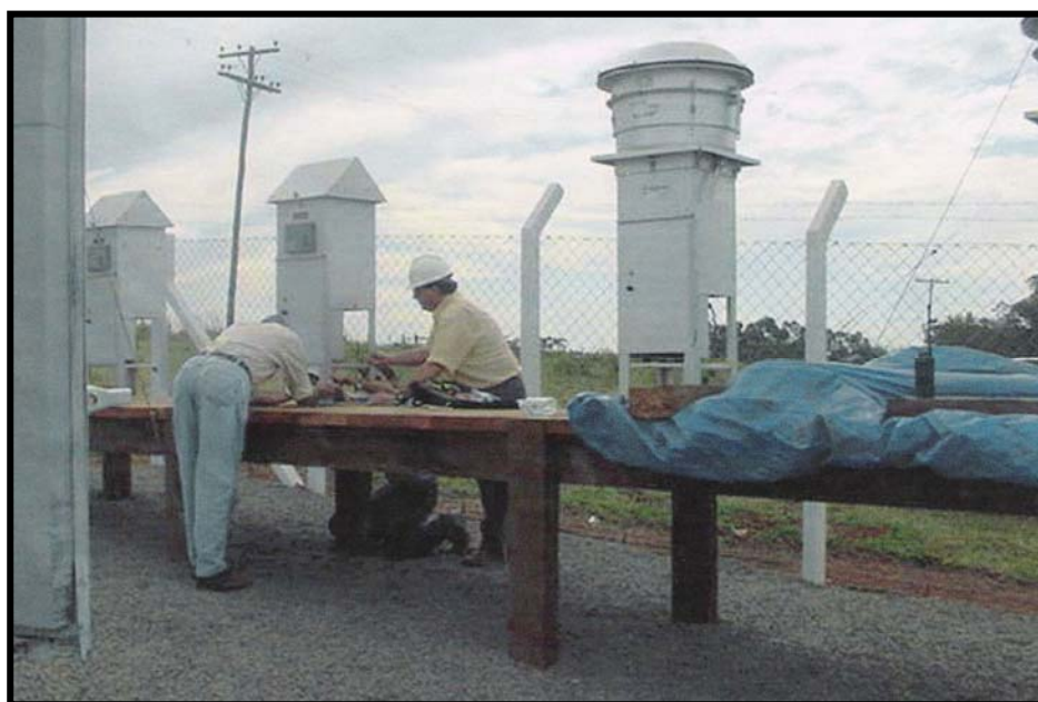
Figura 5 - Fotos de uma Plataforma sendo Montada
